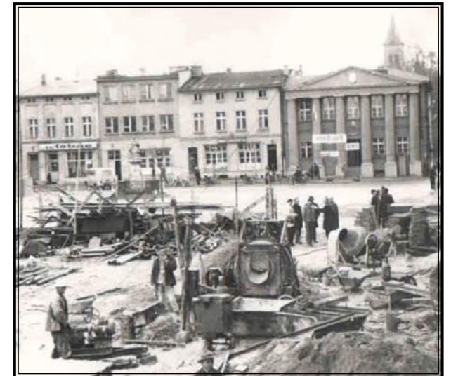
Prace budowlane na placu rynkowym, ze zbiorów Muzeum Regionalnego w Oleśnie
