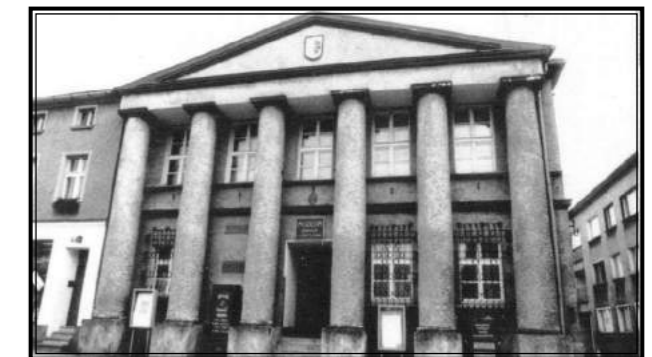
Fasada (elewacja zachodnia), ze zbiorów Archiwum WUOZ w Opolu
