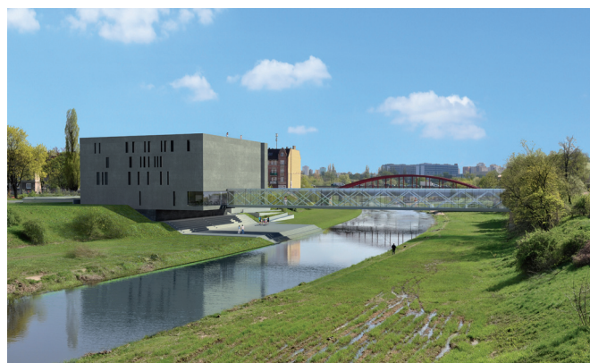
Ryc. 18. Centrum Historii Ostrowa Tumskiego – widok z mostu kolejowego, fot. Ad Artis.
